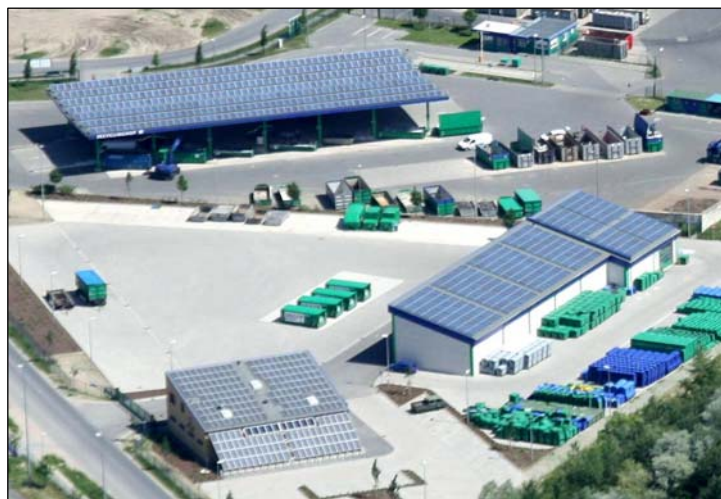
PV-Dachanlagen auf dem Recyclinghof in Niederlehme
