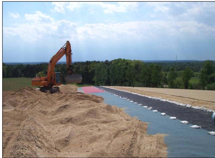
Abdichtung der Deponie Frankenfelder Berg bei Luckenwalde gegen den Austritt von Gasen
